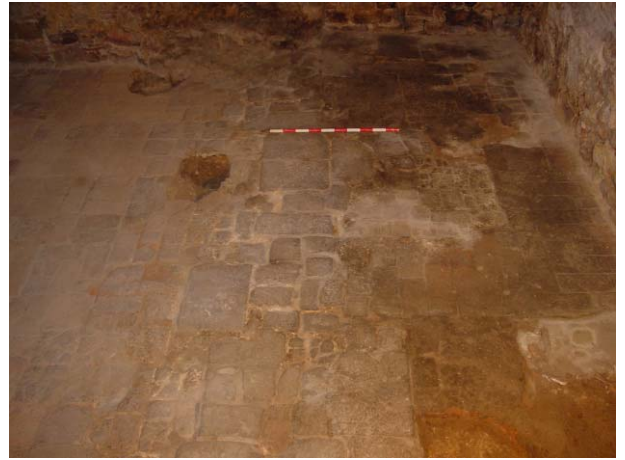
FOTO 90. Hab. 11.1. Fet 32. Estat inicial.
