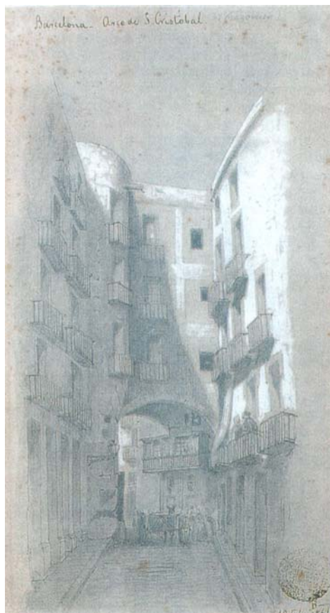
Fig. 3.- El carrer del Regomir amb anterioritat a l'enderroc de l'Arc de Sant Cristòfor. A l'esquerra s'hi observa la torre de planta circular romana encara dempeus.
